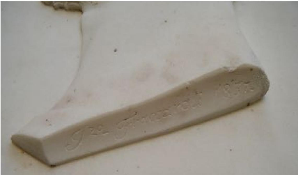
Stuccatura con 2p. polvere di marmo Carrara 1p. calce idraulica NHL3,5
