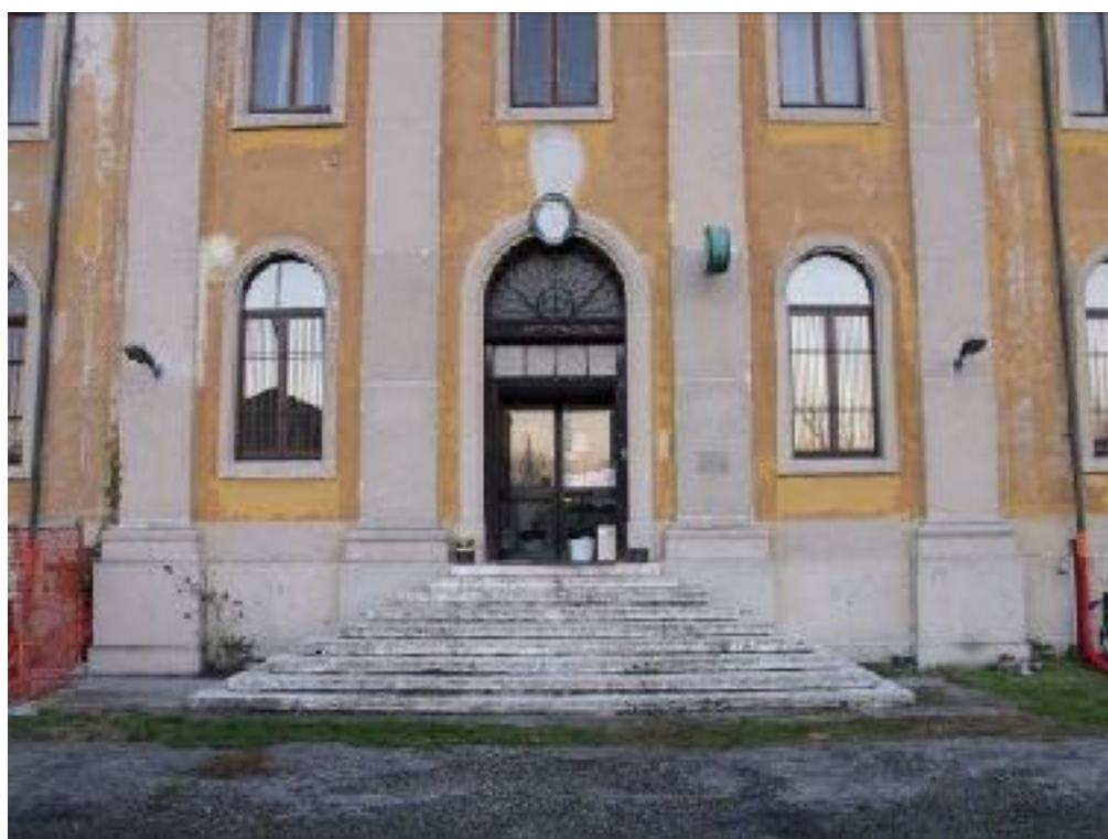
Figura 2 porzione di facciata principale
