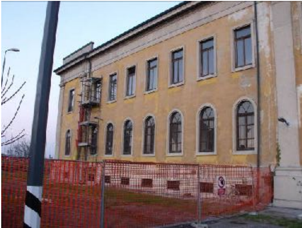
Figura 3 porzione di facciata principale
