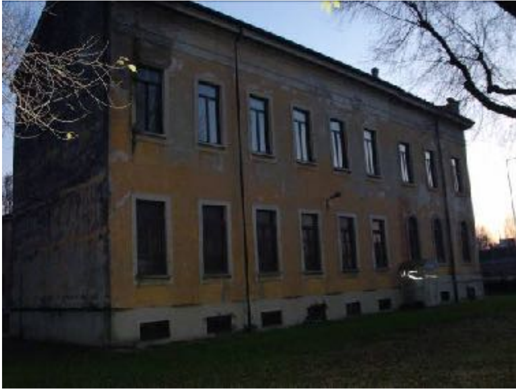
Figura 6 facciata laterale sinistra
