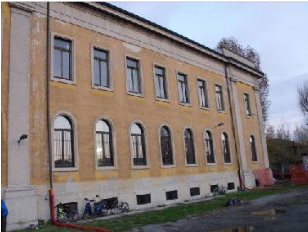
Figura 4 porzione di facciata principale
