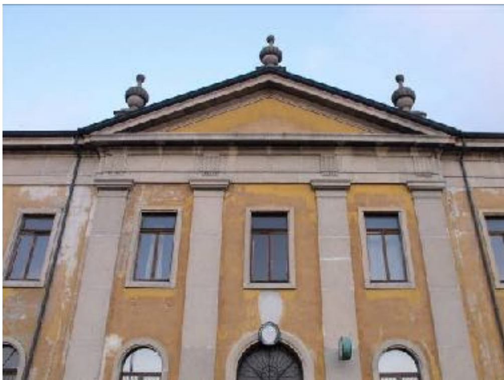
Figura 1 porzione di facciata principale
