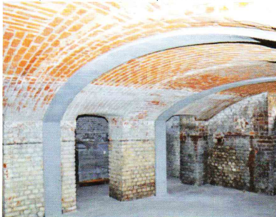
Volte del piano cantina seminterrato dopo il consolidamento
