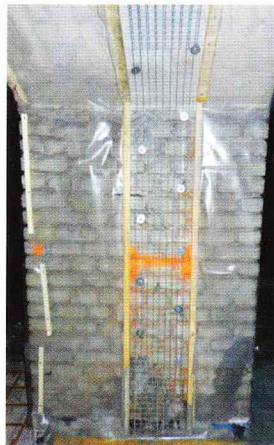
Esempi di costolatura armata e messa in opera di Ecospritz Gunite WLT/TR
