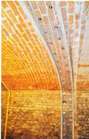
Esempi di costolatura armata e messa in opera di Ecospritz Gunite WLT/TR
