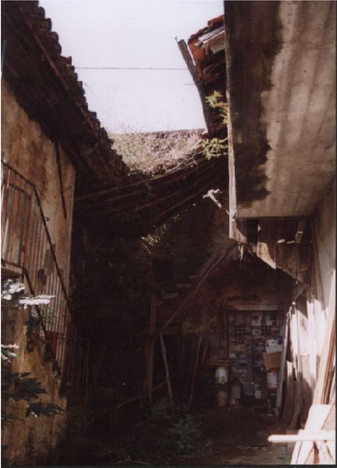
Corte interna mappali 125 e 119
