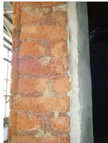
sagramatura spalletta finestra
