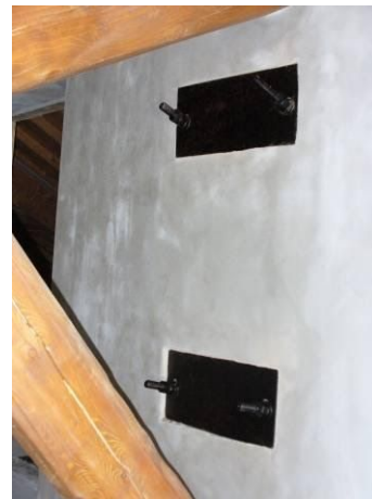
catene metalliche ballatoio
