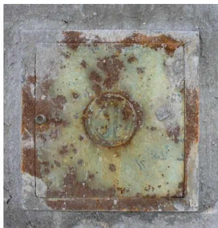
sportello metallico per impianto elettrico
