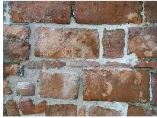
sostituzione dei laterizi allettati con malte non idonee e non allineati
