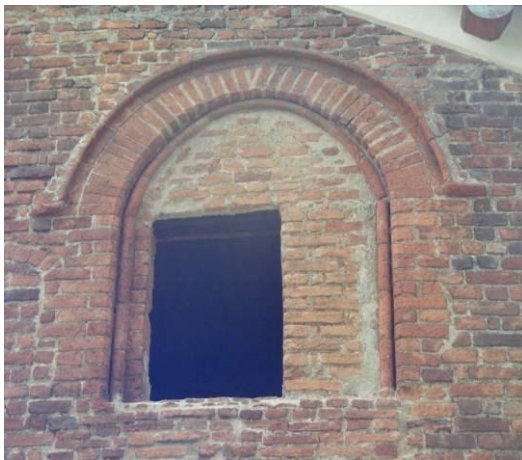
eliminazione della tamponatura
