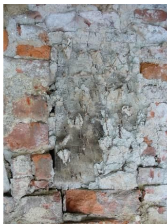
testa di trave in facciata
