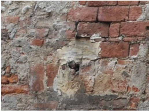
sostituzione dei laterizi allettati con malte non idonee e non allineati
