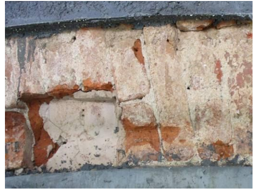
arco '600, lacuna per impianto elettrico
