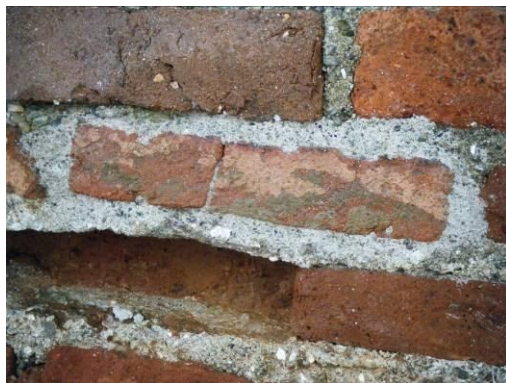
sostituzione laterizi erosi
