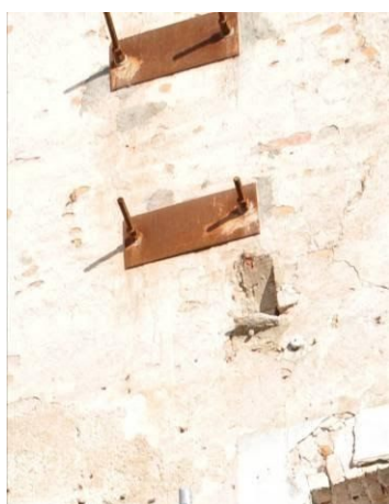
catene metalliche nel ballatoio
