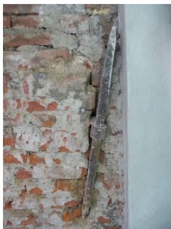
chiave metallica in facciata nord
