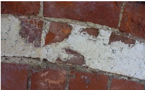
marmorino prima del restauro
