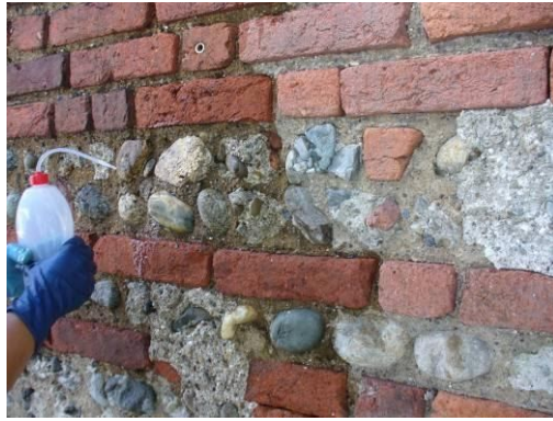
consolidamento con silicato d'etile
