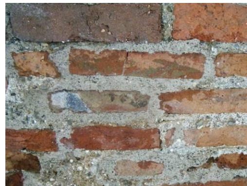
sostituzione laterizi erosi
