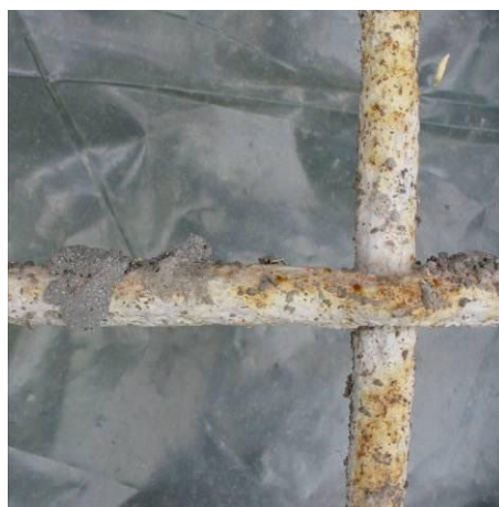
grate metalliche in facciata est
