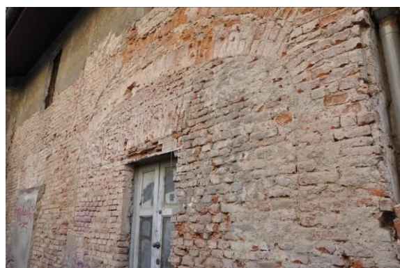
arco '600 prima del restauro
