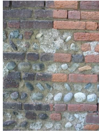
facciata nord, tasselli di pulitura mediante sabbiatura
