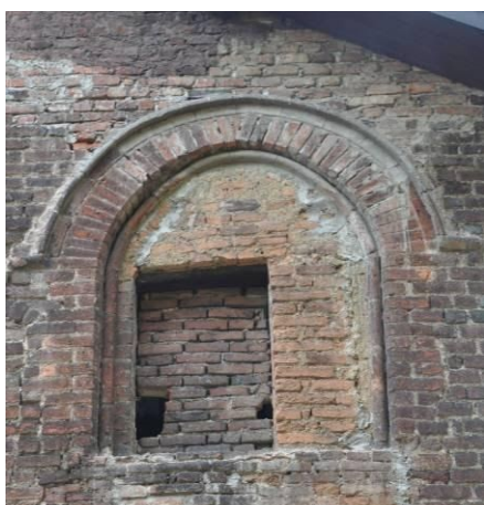
finestra quattrocentesca tamponata
