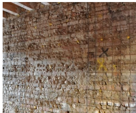
rete per consolidamento strutturale
