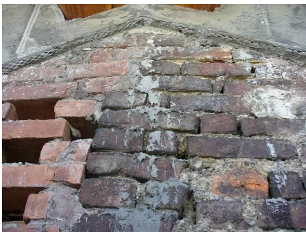
facciata nord colature nella fascia sottotetto
