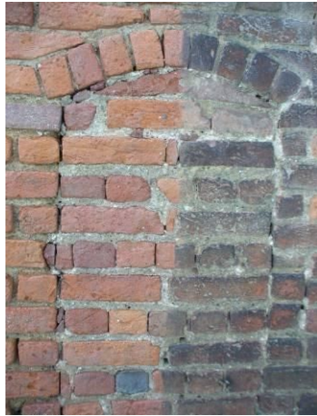
facciata nord, tasselli di pulitura mediante sabbiatura
