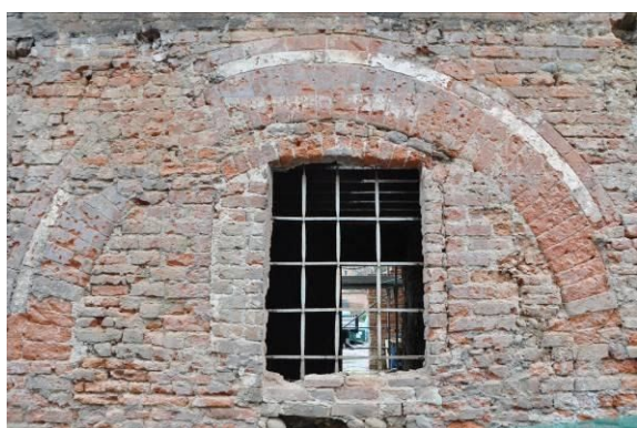
arco '400 prima del restauro
